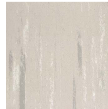
Vinyl Asbestos Tile (VAT) 1974
